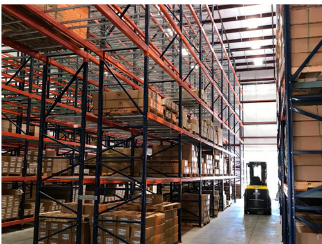
Neubau Lagerhalle in Lexington, USA, Bild 2
